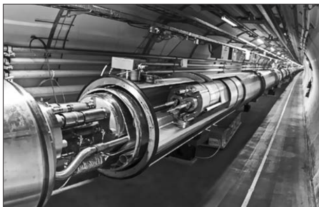
Рис. 2. Две трубы с пучками в диполе БАК и соединение диполов в тоннеле (фото ЦЕРН)
