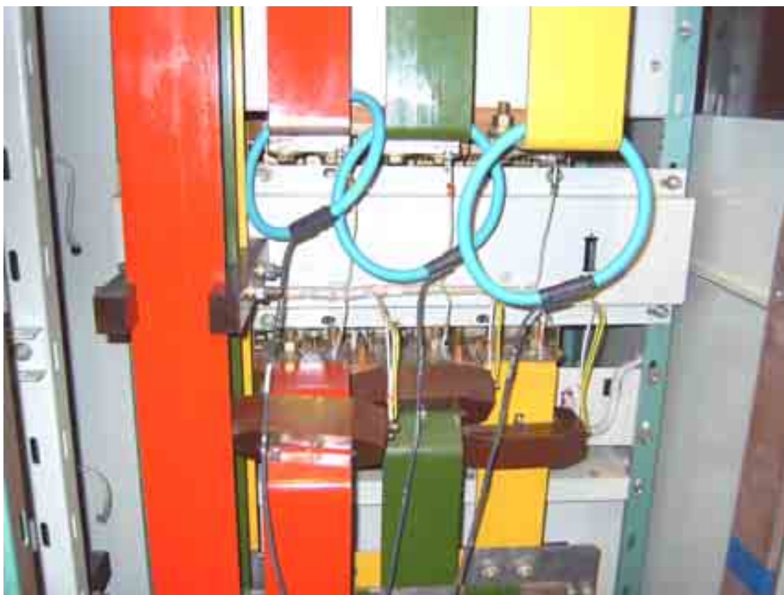
Рис. 7. Подключение гибких датчиков тока
