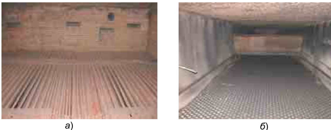
Рис. 3. Состояние КПП (слева) (а) и воздухоподогревателя (б) котла ст. № 3А через полгода после модернизации
